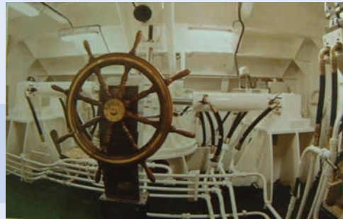
Рулевая машина для аварийных операций на 25 т/м. Emergency operation steering gear 25 T x m.
